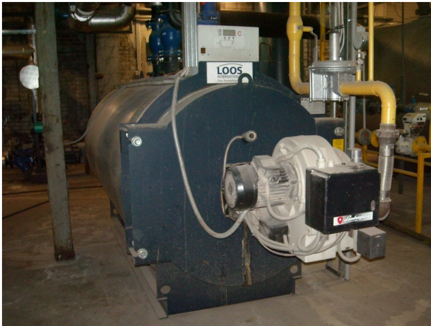
Joonis 3. Kuusalu katlamaja 0,8 MW gaasikatel LOOS G3
