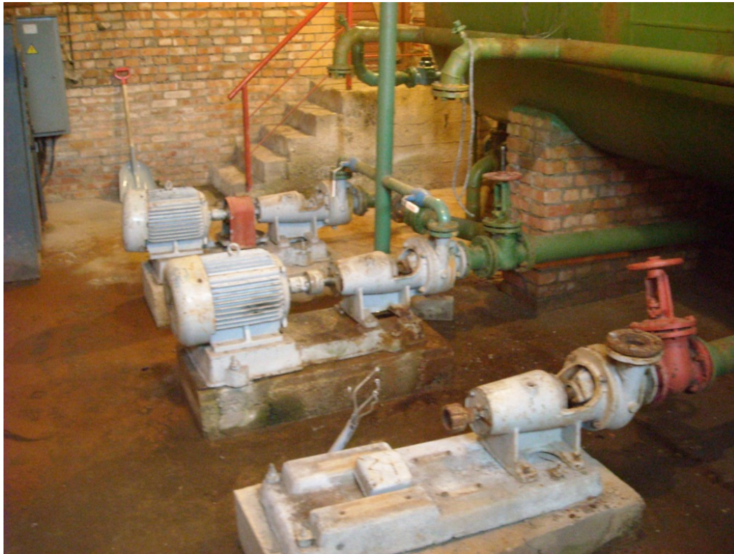
Joonis 9. Kuusalu asula joogivee pumpla nr. 921 tuletõrje pumbad
