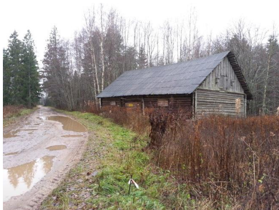
Ala 1. Suru tee ääres Keldripõllu kinnistul asuv taluhuone
