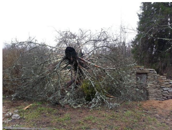
Ala 2. 2013.a laotud maakeldri esisein ja murdunud puu
